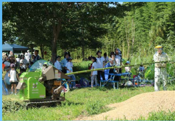
竹林伐採整備作業
